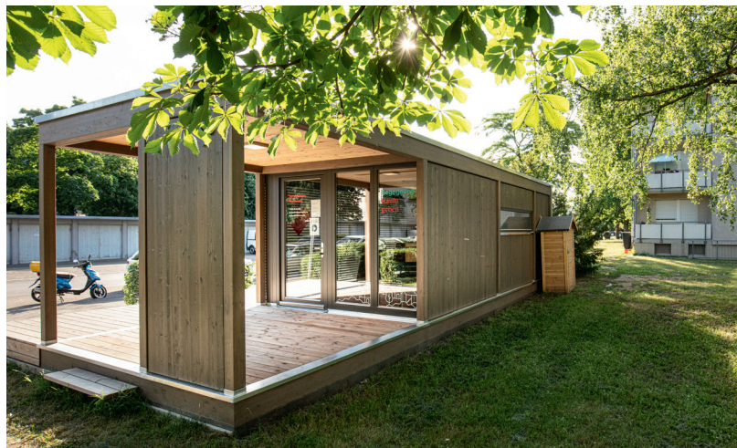
In innovativer Holzbauweise entstand das Servicebüro Nordwest
